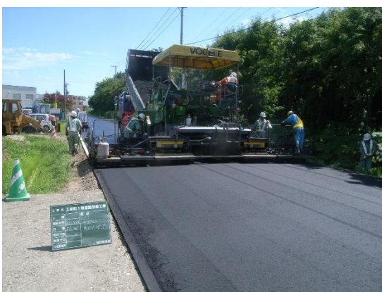
▼道路の路面をきれいにしている工事の様子
