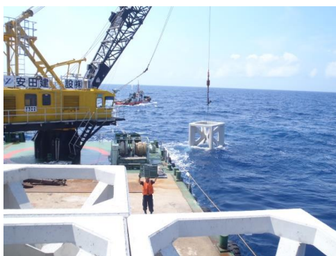
▲起重機船海のマンションの設置の様子。
