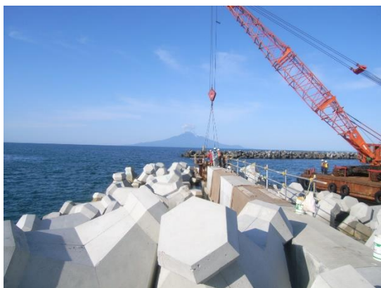
▲港工事の様子。
